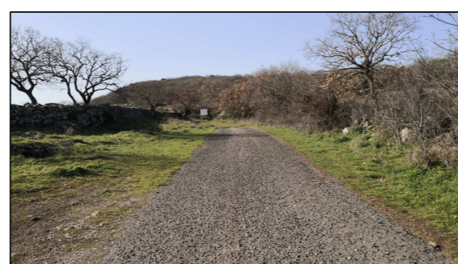
LOCALITÀ OROLO PULIZIA CUNETTE
