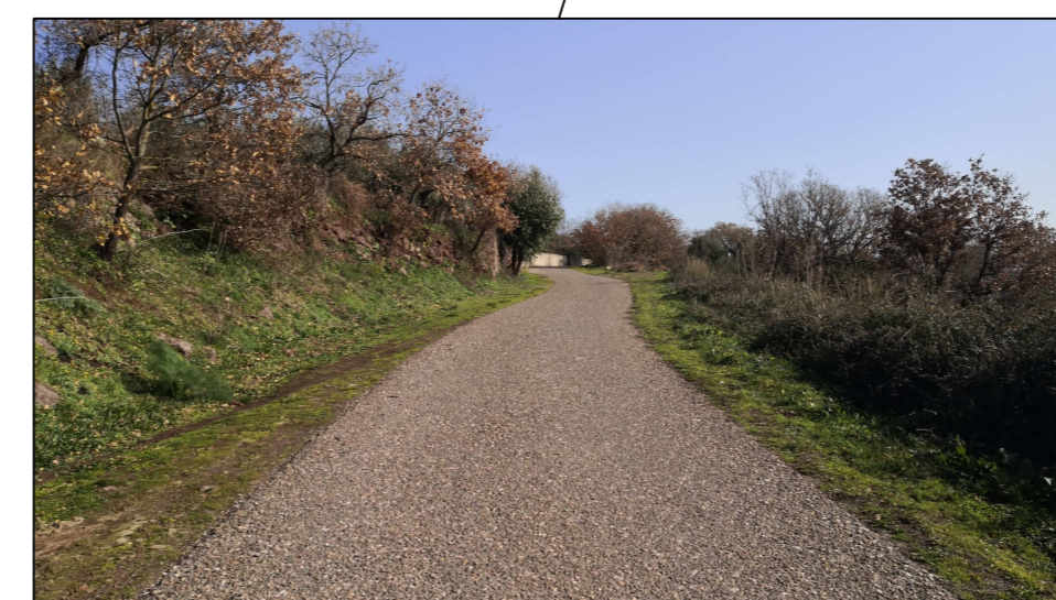
LOCALITÀ PRANU E RUOS PULIZIA CUNETTE
