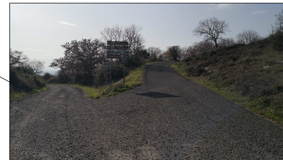
INCROCIO PER NURAGHE OROLO PULIZIA CUNETTE
