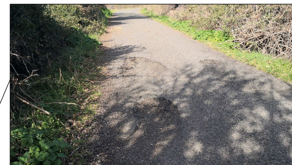
LOCALITÀ LUDRAU RIPRISTINO MANTO USURA AMMALORATO
