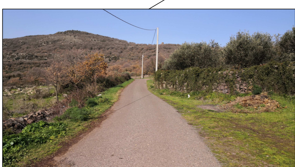
LOCALITÀ MURA SPRENI PULIZIA CUNETTE
